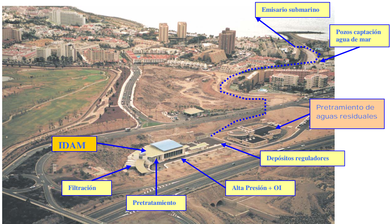
Figura 1. Visión general del sistema de desalación en su configuración inicial.
