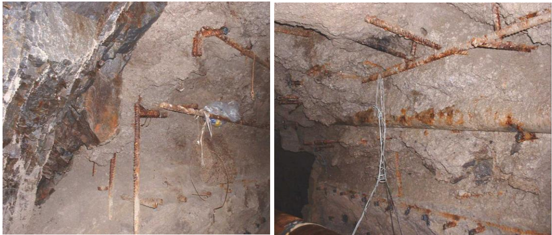
Figura 352.- Restos de las armaduras del muro de cierre después de su demolición.
