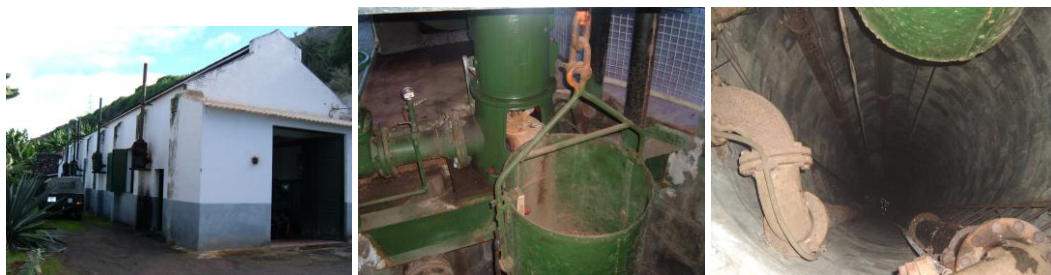
Figura 339. La Coronela: recinto, cubeta o cacharrón y pozo de extracción. (Fuente: CIATF) .
