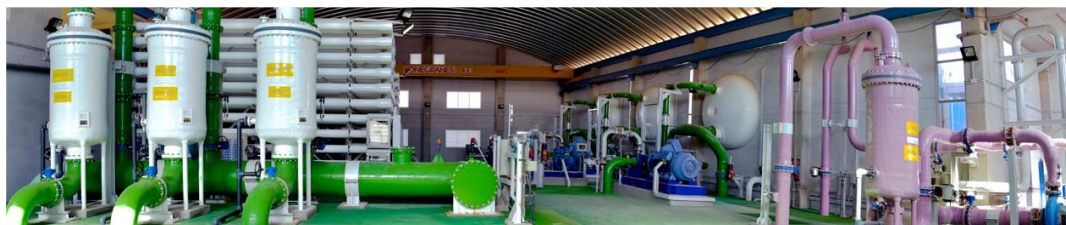
Figura 91. La EDAM de Abona. Diseñada para un horizonte de producción diaria de 42000 m 3 de agua desalada.
