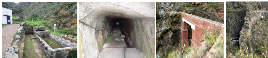
Figura 70. Bocamina (por Roque Negro), interior y canal de la galería Los Catalanes.
