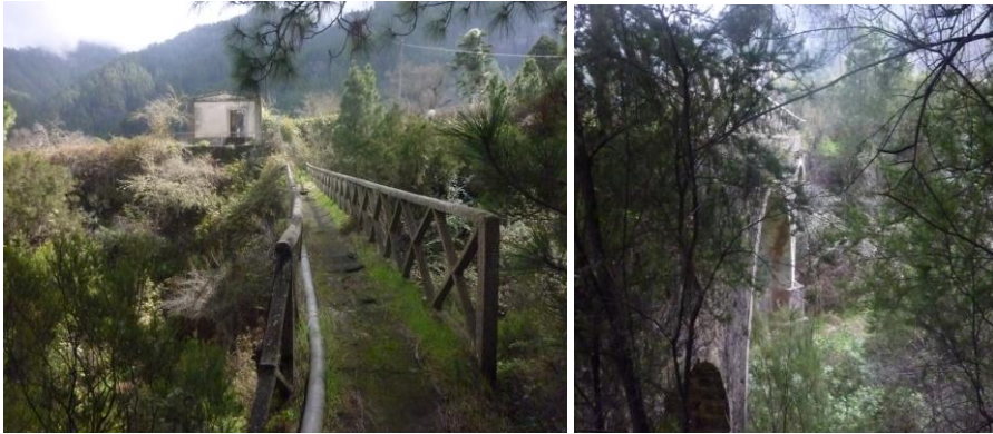
Figura 58. El Canal de La Dula cruzando el barranco en acueducto.
