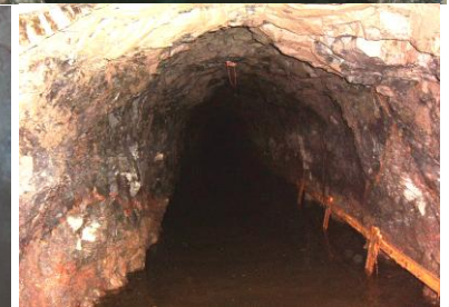
Figura 37. Galerías de fondo perforadas en pozos convencionales. Es común el agua en el piso (Fuente: CIATF).
