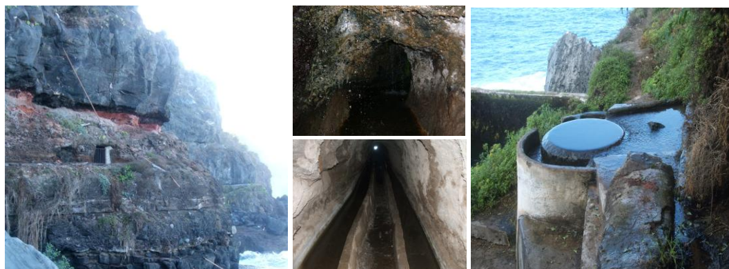
Figura 79. Gª El Molino E: Bocamina (bajo la capa de almagre), interior (ramal y g. principal) y arquilla o pesador.
