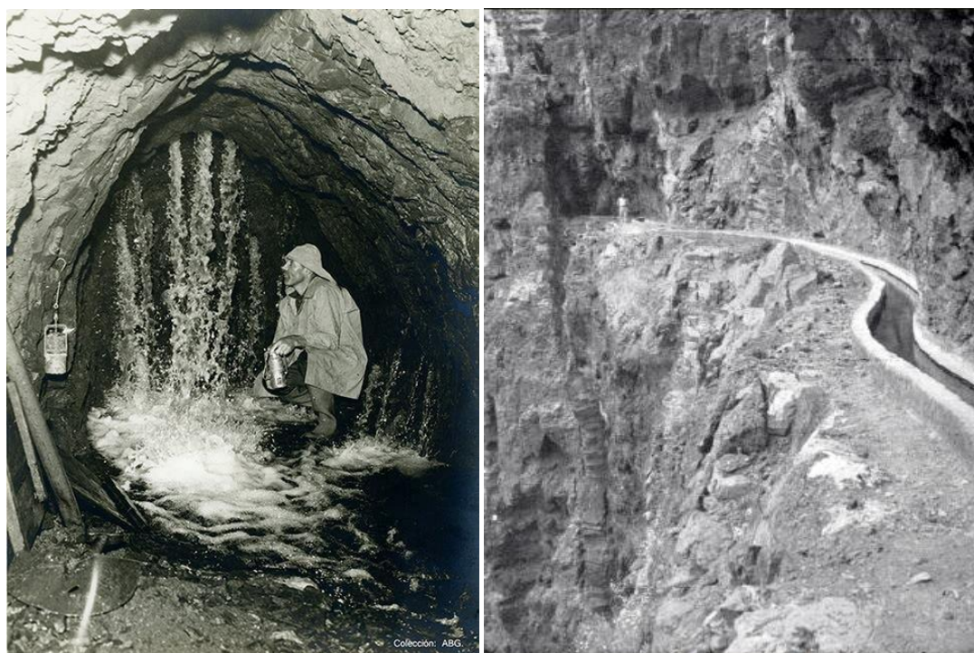
Figura 356.- Izda.: Chorros de agua en el interior de una galería. Dcha.: canal de El Natero
