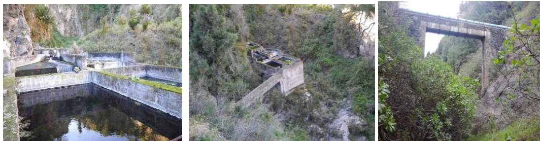
Figura 48. Arquillas de reparto y conducto de transporte y distribución del agua.
