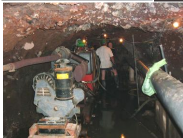
Figura 37. Galerías de fondo perforadas en pozos convencionales. Es común el agua en el piso (Fuente: CIATF).
