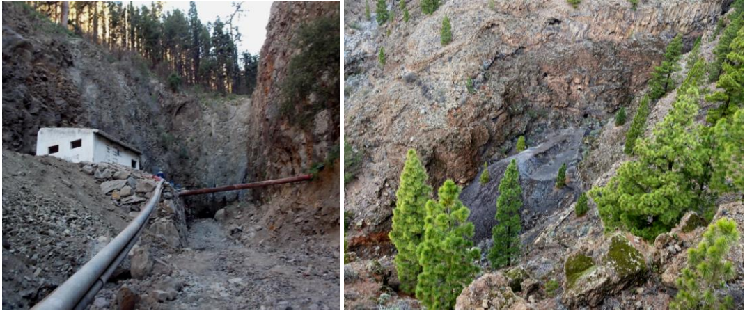
Figura 33. Escombreras en las bocas de las galerías El Junquillo (Guía de Isora) y Barranco de Guaco (Güímar). Su longitud media es de 3000 m., aunque en más de una se superan los 6000 m., siendo de 3350 m. la de las que disponen de agua alumbrada.
