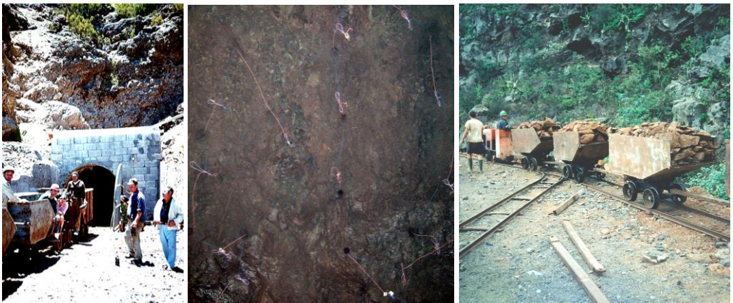
Figura 34. Hace 42 años: cabuqueros aguardando para entrar a recoger los escombros una vez explotase la «pega» (centro). Siglo XXI: una locomotora se encarga de transportar al exterior los carros cargados de escombros.
