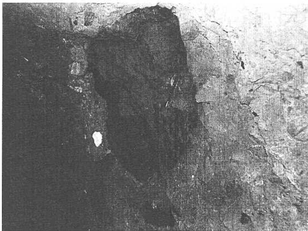
Fig. 6. Aspecto del "mortalón" en el interior de una galería, compuesto por una matriz areno-arcillosa que engloba bloques de distintos tamaños y composición diversa.
